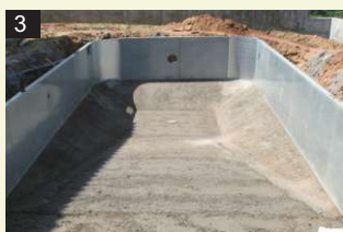
Montaż paneli
